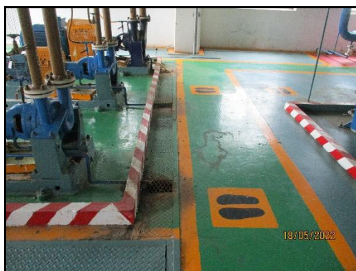
ภาพที่ 2.10 รางระบายน้ำภายในพื้นที่โครงการปรับปรุงและเพิ่มประสิทธิภาพการใช้พลังงานฯ
