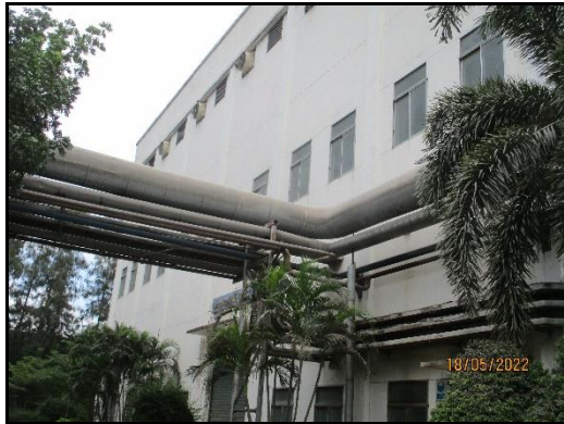
ภาพที่ 2.21 ให้นวนกันความร้อนเครื่องจักรบริเวณโครงการ WHG
