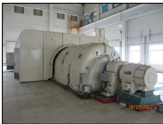
ภาพที่ 2.12 อุปกรณ์ครอบแหล่งกำเนิดที่ก่อให้เกิดเสียงดัง
